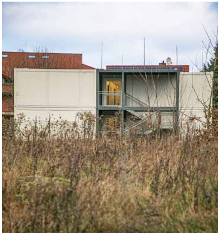
Zukunftsmusik: Die ersten zwei 7. Klassen des neuen Gymnasiums könnten in den Hortcontainern der Storchenschule starten anstatt in einem großen leeren Gebäude.
