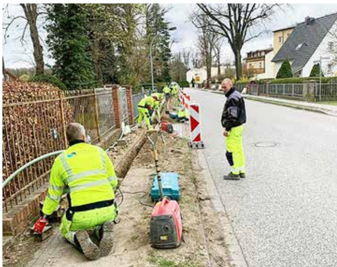
Grabungsarbeiten in Königs Wusterhausen
